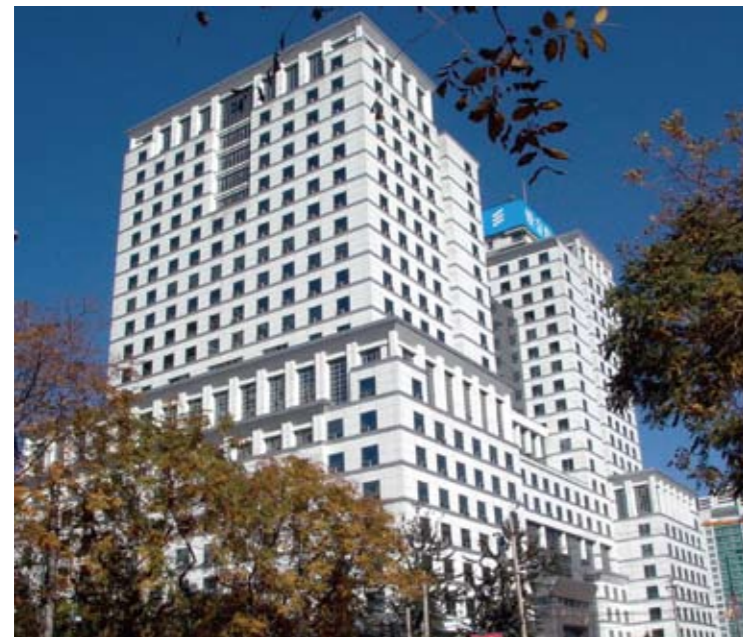
1997 年 7 月，公司总部迁入北京市朝阳区光华路 7 号汉威大厦
